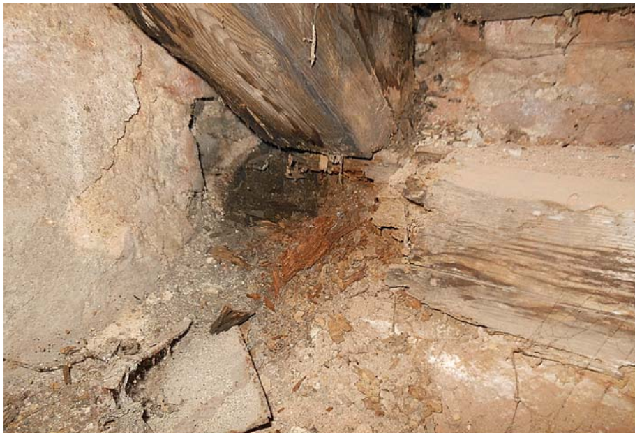
6. ÚPLNÝ ROZPAD POZEDNICE V DŮSLEDKU PŮSOBNÍ KONIOFORY SKLEPNÍ - Coniophora puteana (Schumach.) P. Karst.
